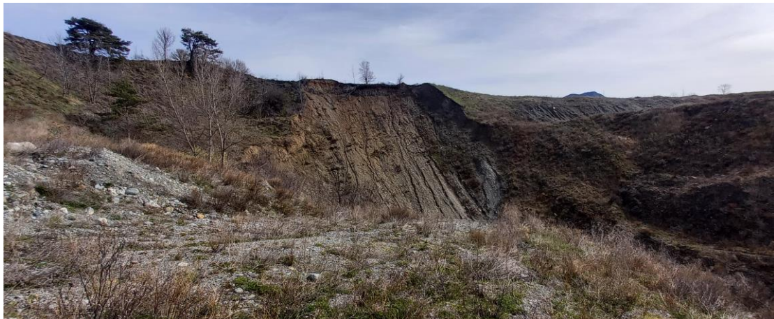
Photographie 31 : Instabilité des terrains périphériques, en limite cadastrale Nord-Est
